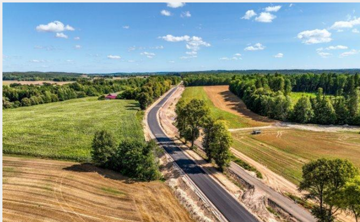
ROZBUDOWA DROGI WOJEWÓDZKIEJ NR 513
