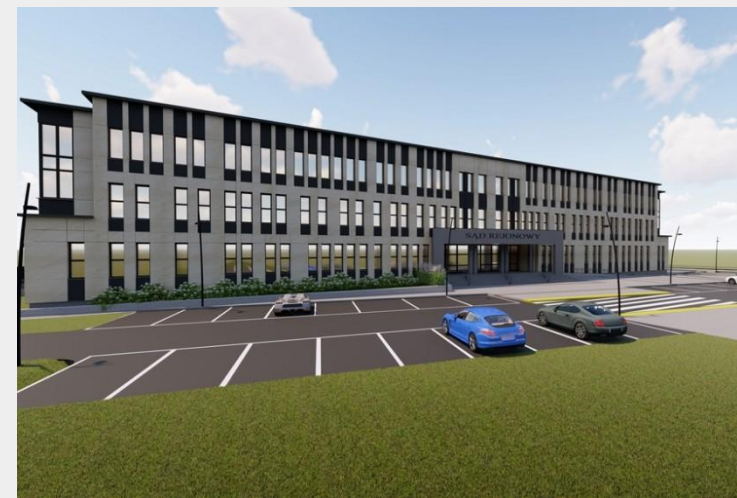
BUDOWA BUDYNKU DLA SĄDU REJONOWEGO W SUWAŁKACH
