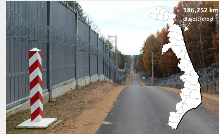
PRZEBUDOWA DROGI TECHNICZNEJ WZDŁUŻ GRANICY Z REPUBLIKĄ BIAŁORUSI
