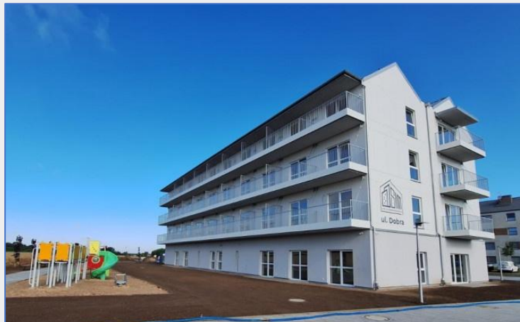
BUDYNEK WIELORODZINNY SIM, ŚWIDWIN, POLSKA
