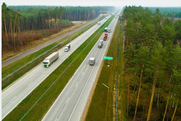
ROZBUDOWA S8 WRAZ Z OBIEKTAMI MOSTOWYMI
