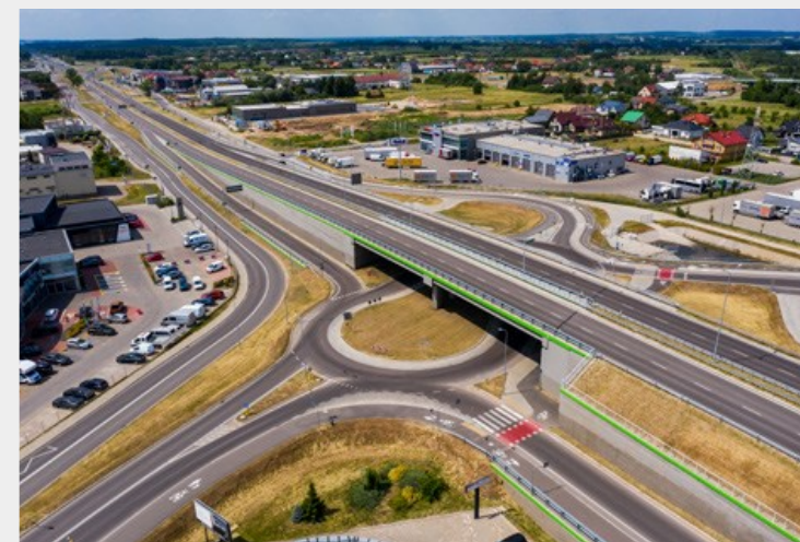
BUDOWA WĘZŁA DROGOWEGO W POROSŁACH
